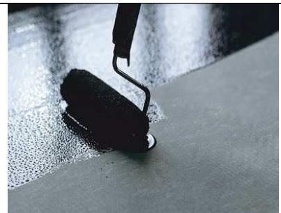
پوششی بر پایه ترکیبات نفتی (کولتار اصلاح شده) که برای پوشش سطوح فولادی و سیمانی در محیط‌های دریایی و زیر خاک مورد مصرف قرار می‌گیرد. این محصول مقاومت خوبی نسبت به آب و آب دریا دارد اما استفاده از آن در مجاورت اسیدها، قلیاهای، حلال‌های آروماتیک، حلال‌های اکسیژن‌دار و دمای بالای ۸۰° توصیه نمی‌شود. این پوشش به دلیل داشتن کولتار اصلاح شده در برابر حملات میکروبی و باکتری‌ها بسیار مقاوم است.
