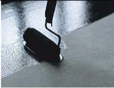
پوششی بر پایه ترکیبات نفتی (کولتار اصلاح شده) که برای پوشش سطوح فولادی و سیمانی در محیط های دریایی و زیر خاک مورد مصرف قرار می گیرد. این محصول مقاومت خوبی نسبت به آب و آب دریا دارد اما استفاده از آن در مجاورت اسیدها، قلیاها، حلال های آروماتیک، حلال های اکسیژن دار و دمای بالای  $80^{\circ}$  توصیه نمی شود. این پوشش به دلیل داشتن کولتار اصلاح شده در برابر حملات میکروبی و باکتری ها بسیار مقاوم است.
